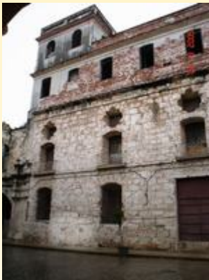
Figura 5. Extremo sur de la fachada del Convento de Belén; más claro que el resto, el sector donde se encontraba la fuente y donde se localizan sus huellas.
