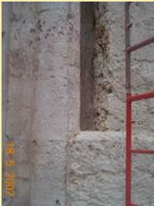
Figura 4. Cala realizada en la pilastra que separa los Arcos del edificio, donde se aprecia, a 0.90 metros por debajo de la actual, la existencia de la línea de fachada original, así como la continuidad de la pilastra asociada a la misma.
