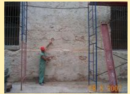
Figura 6. Detalle del extremo sur de la fachada donde se aprecian las evidencias de la última fuente del Convento.
