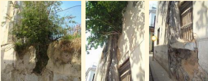
Fig.4 Ejemplos del grado de afectación físico mecánica que puede provocar el crecimiento de las raíces dentro de la estructura de los muros de las edificaciones. Fotografías tomadas en la fachada sur del CENCREM.
