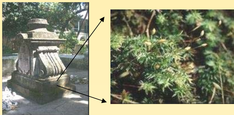
Fig.1 Crecimiento de musgos sobre estructura pétreo en el Aljibe del patio del Primer Claustro del Convento de Santa Clara.
